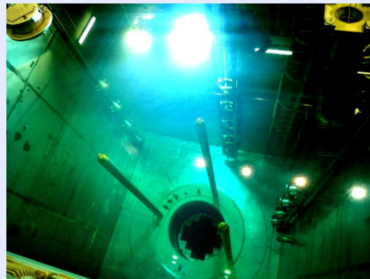
ハロゲン&LED水中照明(2台)点灯
