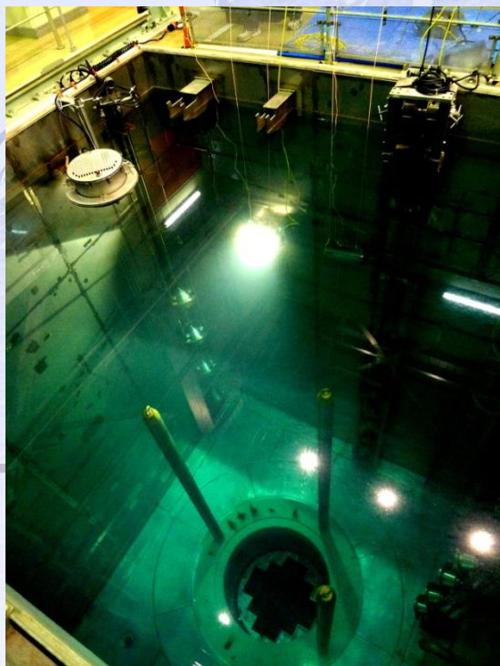
仏国ECE社製ハロゲン水中照明 (照射角75度仕様/1台点灯時)
